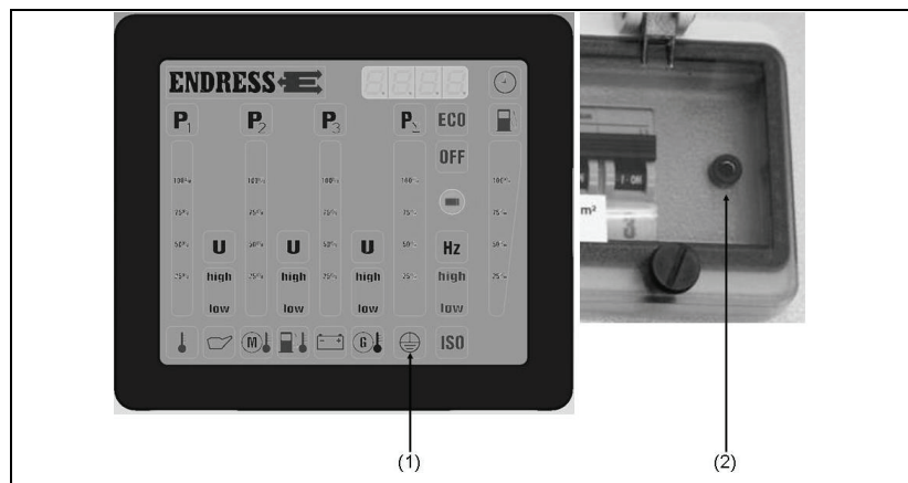
rys. 4-6: Sprawdzanie przewodu ochronnego
