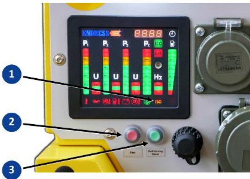
Sl. 8-4 Kontrola izolacije
