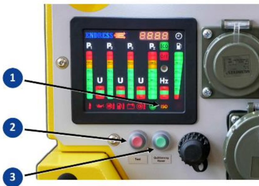
Sl. 8-3 Kontrola izolacije
