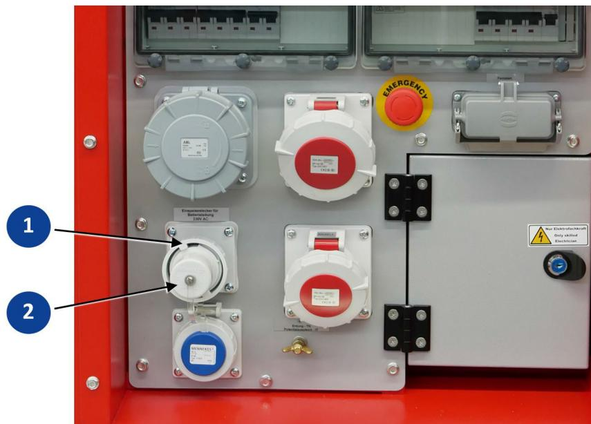
Abb. 9-2 Einspeisestecker 230V zur Batterieladung
