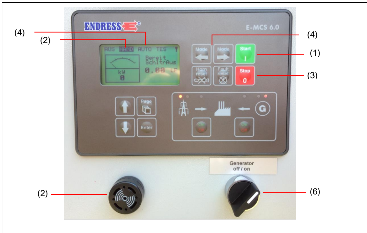
Fig. 81: Arrancar el generador eléctrico manualmente
