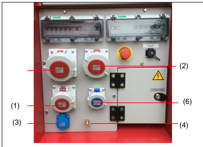
Fig. 83: Conectar los consumidores a través de los enchufes
