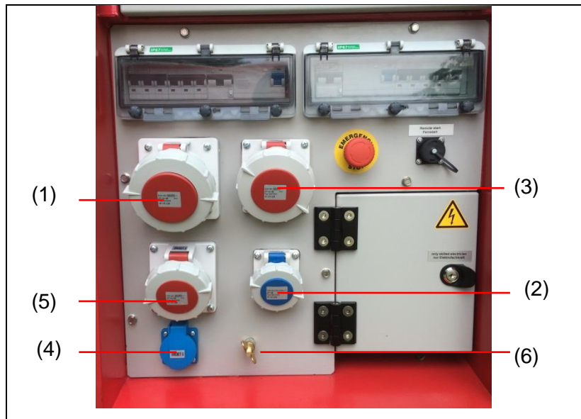
Illustration 8-3 : Brancher un équipement dans les prises
