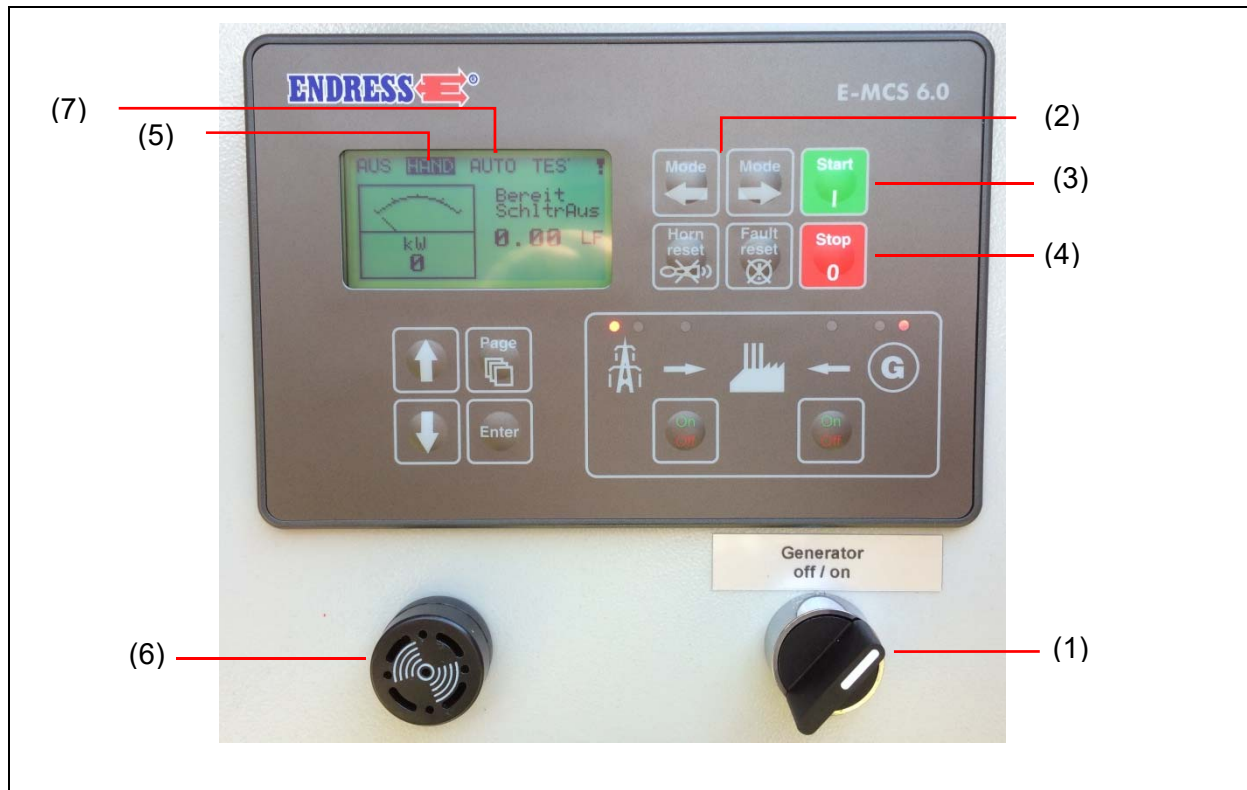
Рис. 8-1: Запуск электрогенератора вручную
